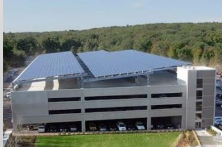
Solar PV (1-3 MW)
