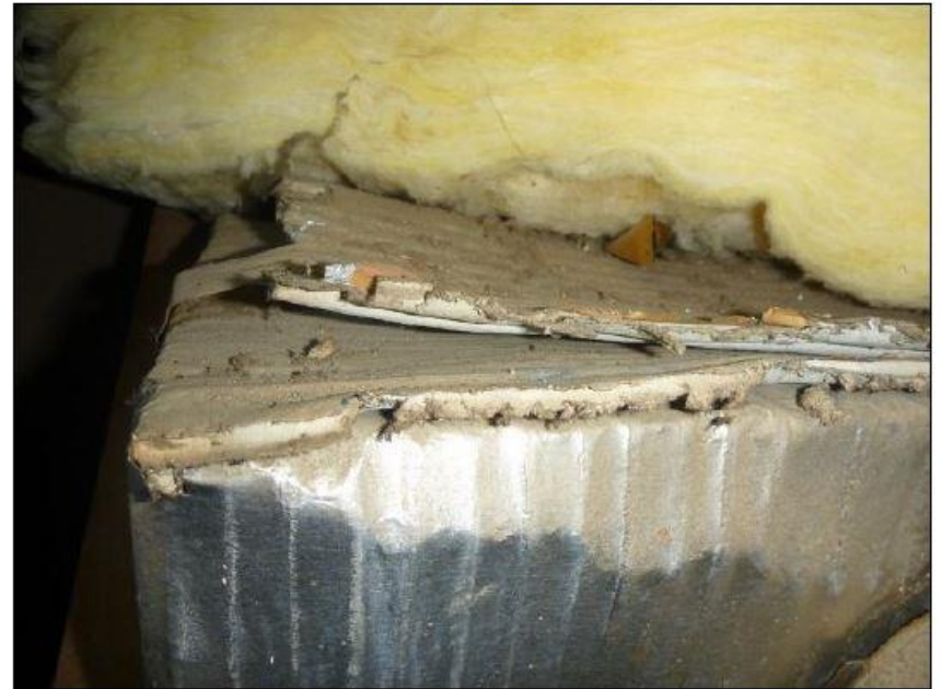
Friable asbestos wrapped air plenum:
