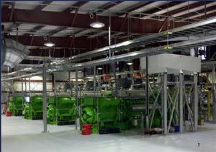
JBER: Landfill-Gas-To Energy Project
