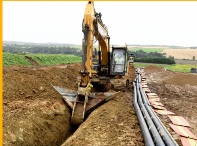
Converter station route. Ruta a estación convertidora.
