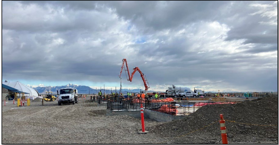
Construction crews pour floor slabs of PSB II
