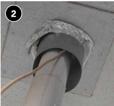
Represa alrededor de conductos de humos de alta temperatura (*nota: el conducto de humos en la imagen requiere trabajo*).
