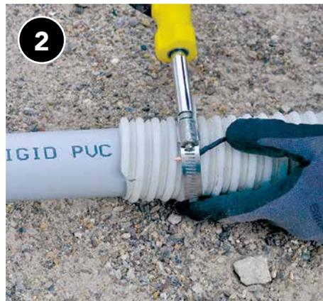
2 Sujete un trozo de alambre de cobre a un conector de metal para descargar la electricidad estática acumulada.
