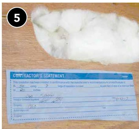
5 Al terminar, coloque un certificado/constancia de aislamiento fechado y firmado por el instalador con la información requerida (p. ej., tipo de aislamiento, área aislada, espesor, etc.).
