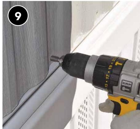
9 Vuelva a colocar los sujetadores mecánicos.
