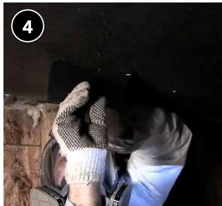
4 Corte orificios de acceso para garantizar que toda la cavidad reciba un aislamiento continuo y consistente.
