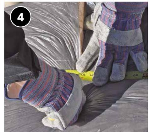
Corte la guata a la medida de la cavidad y recorte el ancho si es necesario para asegurar un correcto ajuste.
