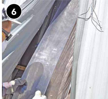
6 Inserte la guata en la cavidad, insertándola a lo largo de la hilada saliente superior hasta la parte superior de la cavidad, y tire de la herramienta de relleno para permitir que la guata llene el espacio.
