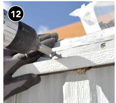
12 Vuelva a colocar el canal J sobre el borde del techo. Repita todo el proceso del otro lado, si es necesario.
