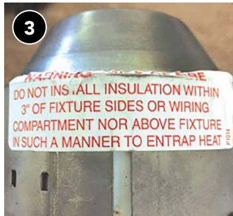
Reemplace las luces empotradas con clasificación de contacto sin aislamiento por luces empotradas con clasificación de contacto con aislamiento.
