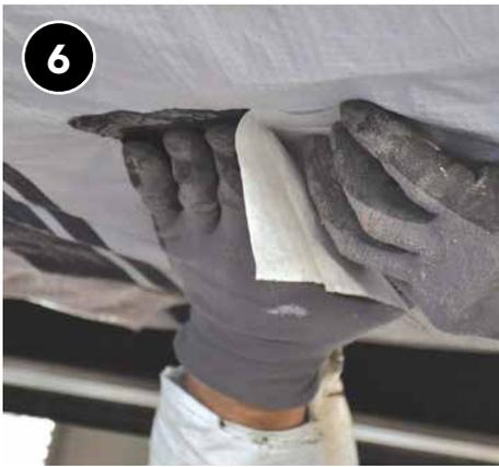
6 Aplique adhesivo permanente e impermeable al parche para el revestimiento de la faja central, con un tamaño de parche de al menos 3 pulgadas más grande que el orificio de la barrera.
