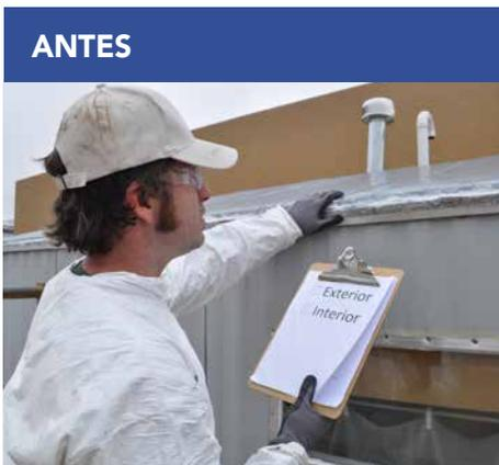
Confirme la integridad estructural del ensamblaje del techo y verifique que no existan filtraciones activas en el mismo antes de la instalación.
