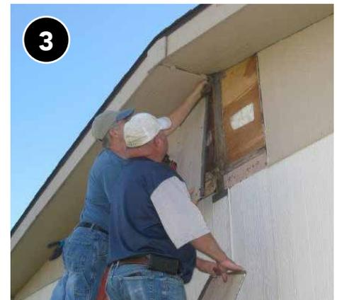
3 Retire o doble con cuidado el material de revestimiento del hastial para acceder al ático. El acceso también se puede lograr retirando las ventilaciones del hastial existentes o instalando otras nuevas.
