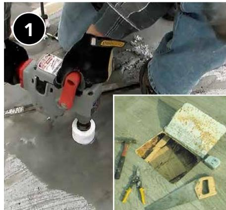
Corte orificios de acceso (orificios rectangulares o redondos) lo suficientemente grandes como para que quepa un tubo de llenado en cada cavidad.
