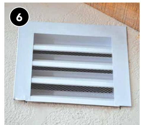
6 Según el método de acceso, vuelva a sellar el material de revestimiento del hastial o instale ventilas con una rejilla de no más de 1/4 de pulgada. Repita todos los pasos del otro lado según sea necesario para garantizar una cobertura adecuada.
