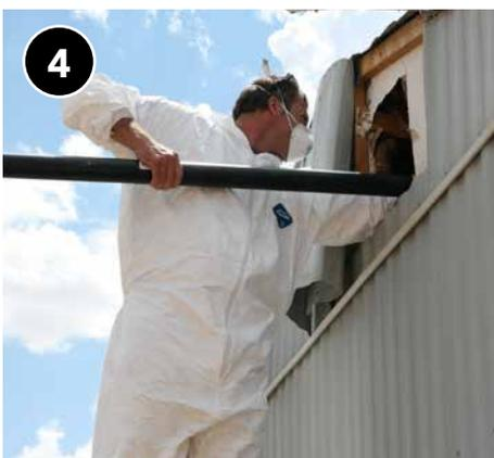
4 Inserte el tubo de relleno de aislamiento tanto como sea posible, moviéndolo de lado a lado mientras lo retrae lentamente para asegurar una cobertura de aislamiento adecuada. Si hay una doble pared, utilice esta técnica en cada lado de la pared.
