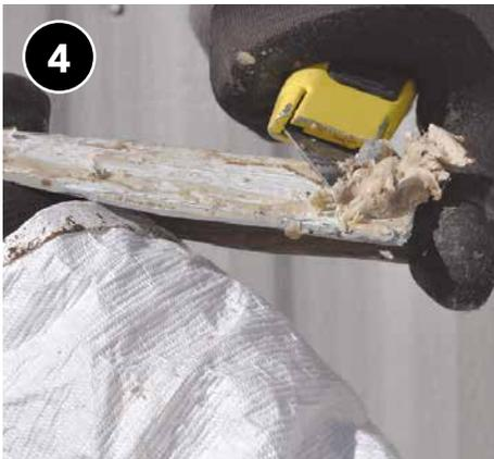
4 Limpie la cinta de butilo vieja o la masilla del canal J y guarde el canal J en un lugar seguro hasta que pueda volver a instalarlo.
