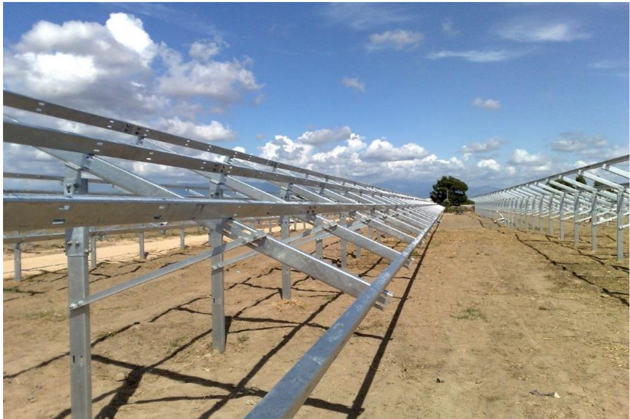
Figura 7. Estructura de base fija
