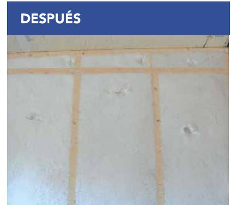
Cuando se aísla correctamente, el rendimiento térmico de la pared mejora y disminuyen las fugas de aire.
