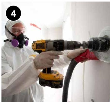
4 Perfore orificios de acceso al aislamiento según sea necesario para asegurar la cobertura completa de todas las cavidades de la pared sin aislamiento.
