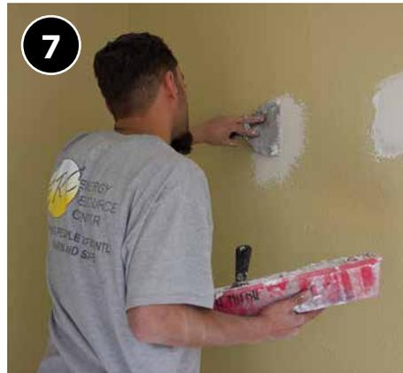
Parche los orificios de acceso al aislamiento o utilice un guardasillas para cubrir los orificios.
