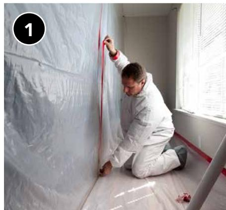
1 Proteja el piso debajo del área de trabajo y utilice carcasas de contención para evitar la propagación de polvo y escombros.
