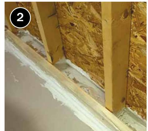
2 Asegúrese de que las paredes con armazón de globo estén sujetas a la parte superior e inferior para evitar que el aislamiento se traspase accidentalmente hacia el ático o el sótano.
