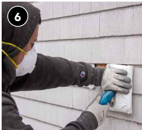
Utilizando un tubo de llenado por inyección, aisle todas las cavidades de acuerdo con la densidad correcta.
