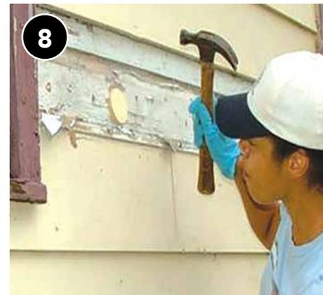
Tape y selle los orificios de acceso al aislamiento. Cuando esté presente, repare la barrera resistente al agua para evitar la intrusión de agua.
