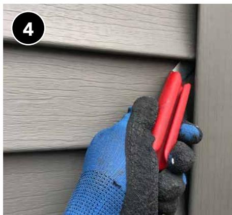
4 Retire el entablado que sea necesario, dependiendo del tipo de material del revestimiento exterior. Muchos tipos de entablado (p. ej., vinilo, aluminio, acero) se pueden aflojar con una herramienta para entablado.
