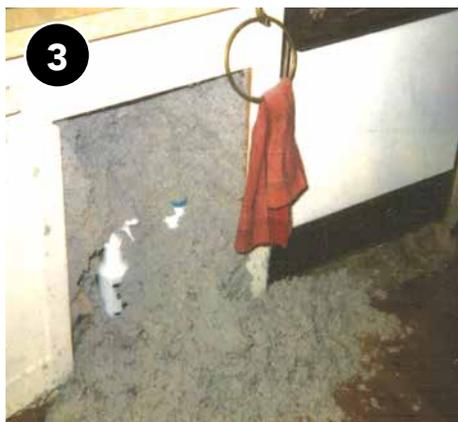
3 Confirme que la integridad de la pared pueda soportar la presión del aire del aislamiento soplado y asegúrese de que todos los orificios estén reparados para evitar que el aislamiento se reviente.
