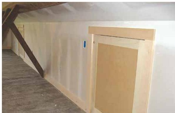
Separe todos los productos de espuma del espacio habitable con un material de barrera térmica, como paneles de yeso de 1/2 pulgada. Además, si el ático se destina exclusivamente a las instalaciones de servicios públicos, la espuma se separará del espacio del ático utilizando una barrera de ignición adecuada. Si el espacio del ático se utiliza como almacén o habitación, la espuma en aerosol se separará del ático usando una barrera térmica adecuada.
