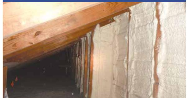
Rocíe las paredes lo más uniformemente posible con el espesor indicado para lograr el valor R deseado. Consulte con el fabricante para determinar el valor R correcto por pulgada, ya que puede variar en función del fabricante.
