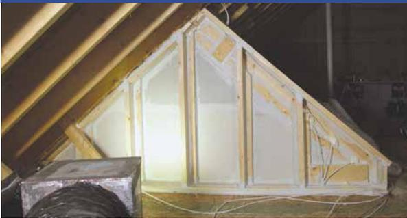
Instale material de respaldo duradero en todos los huecos grandes antes de aplicar espuma en aerosol para evitar que la espuma se filtre al espacio acondicionado. Todas las superficies en contacto con la espuma deben estar libres de polvo y residuos. Ventile el espacio de trabajo siguiendo las especificaciones del fabricante para asegurar que los trabajadores y los ocupantes estén protegidos de los vapores de espuma en aerosol durante y después de la instalación.
