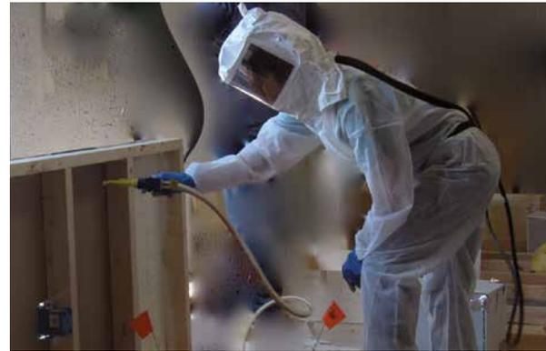
Asegúrese de que los instaladores usen el equipo de protección personal necesario (respiratorio, piel/cuerpo y ojos). Siga las instrucciones de temperatura especificadas por el fabricante para el aire ambiente, la superficie y los productos químicos a fin de evitar fallas en el producto.
