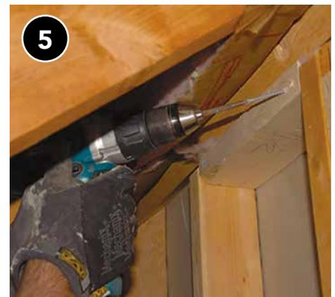
Si se requiere una placa superior, fije la madera en su lugar con sujetadores mecánicos.
