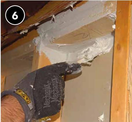
Selle el bloqueo con resina mástic, impermeabilizante o espuma de un componente para mantener la barrera de presión y evitar el movimiento de aire dentro de la cavidad.
