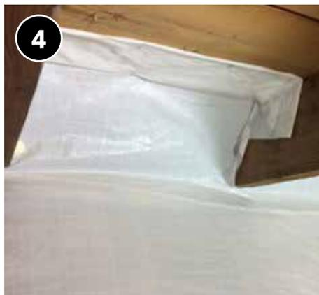
Un método alternativo a los pasos 1 a 3 es utilizar espuma rígida o material de envoltura de la casa hasta la cubierta del techo para bloquear la abertura y crear un sellado de fugas de aire cuando los bordes del material estén sellados en relación con el armazón.
