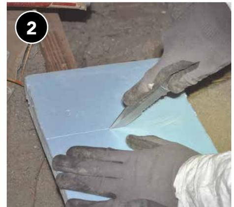
Corte el material de bloqueo (poliestireno extruido, madera, placa de yeso) para que encaje en el hueco.
