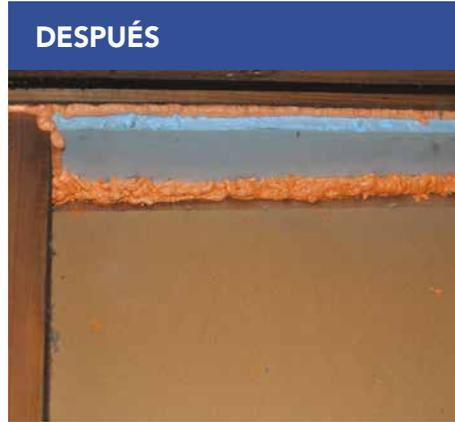
El sellado de fugas de aire en la parte superior de un muro en desnivel da continuidad a la barrera de presión mientras soporta el aislamiento adicional desde el muro en desnivel o la viga del techo de arriba.
