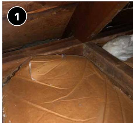
Después de retirar los desechos, mida el hueco por encima del muro en desnivel en línea con la barrera de presión.
