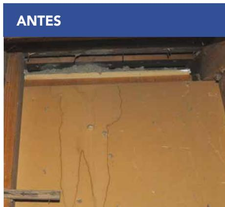
Los muros en desnivel a menudo definen la barrera térmica y de presión. Por encima del muro en desnivel suele haber una cavidad de viga de techo abierta que podría necesitar bloqueo, o el muro en desnivel podría carecer de una placa superior.
