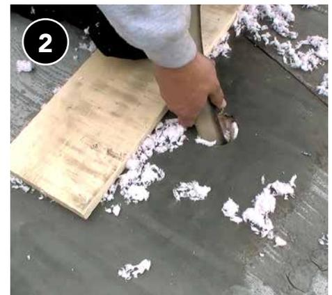
Inserte con cuidado un tubo de llenado y aisle todas las áreas de acuerdo con la densidad correcta, utilizando aislamiento de fibra de vidrio.
