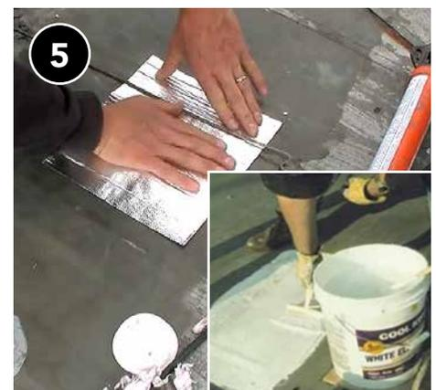
Instale un parche adhesivo y flexible para techo sobre el primer parche. Al terminar, aplique una capa final de pintura elastomérica sobre el área afectada.
