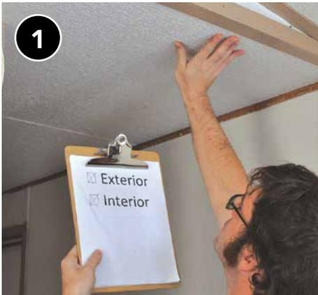
1 Verifique la integridad del techo para asegurarse de que pueda soportar el peso del aislamiento adicional.
