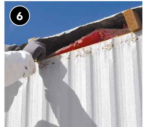
6 Inserte bloques para sostener el borde del techo aproximadamente a 6 pulgadas.
