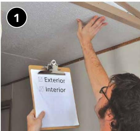
1 Verifique la integridad del techo interior para asegurarse de que pueda soportar el peso del aislamiento adicional.
