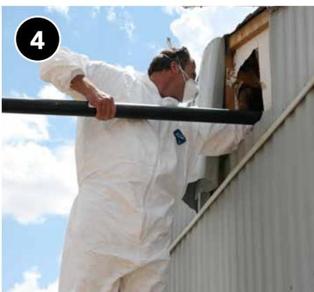
4 Inserte el tubo de relleno de aislamiento tanto como sea posible, moviéndolo de lado a lado mientras lo retrae lentamente para asegurar una cobertura de aislamiento adecuada. Si hay una doble pared, utilice esta técnica en cada lado de la pared.
