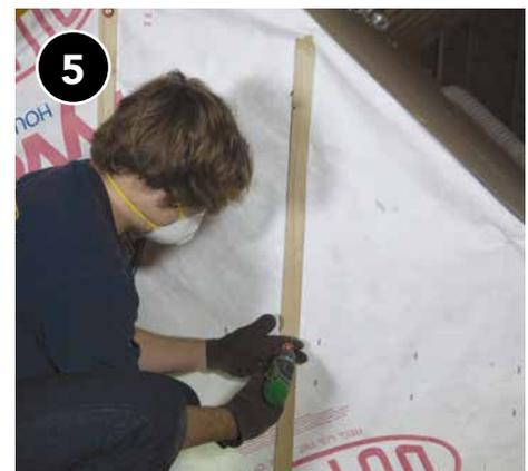
Para aislamiento con guatas, cubra las guatas instaladas con soporte. Para el soplado, fije la red a los miembros estructurales, corte orificios en la red y sople el aislamiento a una densidad instalada de 3,5 libras por pie cúbico.
