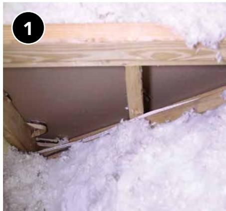
Si las paredes que definen la barrera térmica son accesibles desde el lado del ático, elija entre aislamiento de guata o soplado.
