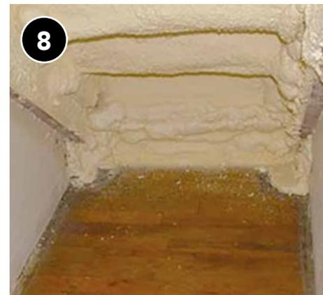
Si las escaleras no tienen material de soporte (p. ej., paneles de yeso, yeso, etc.) del lado de la casa o del espacio acondicionado, realice el aislamiento con el material indicado en la orden de trabajo.
