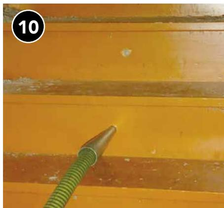
Si la parte trasera de las escaleras ya tiene material de soporte, sople el aislamiento en la cavidad detrás de las escaleras.
