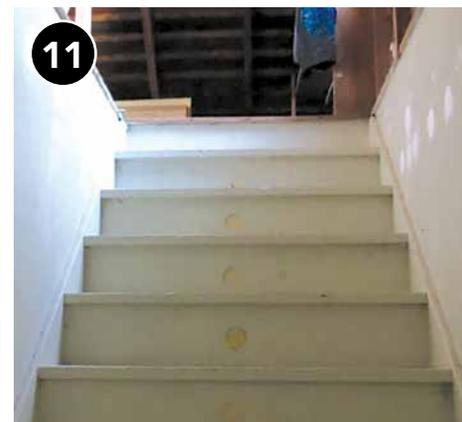
Tape los orificios de acceso para el aislamiento soplado.
