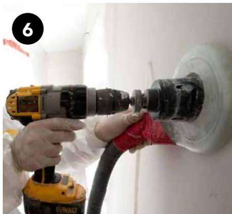
Si las paredes están cerradas desde el lado del ático, taladre orificios en las paredes de las escaleras para definir la barrera térmica.
