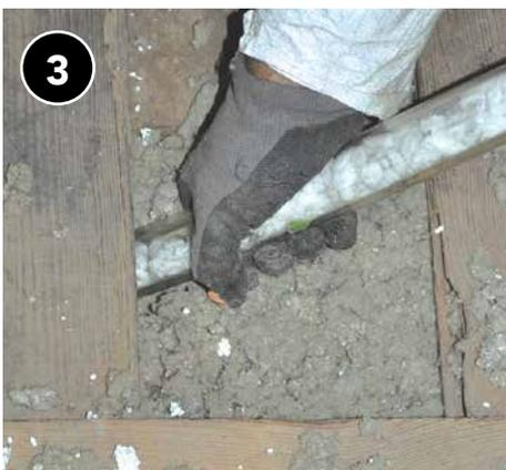
Rellene toda la cavidad con aislamiento hasta la densidad indicada. Vuelva a instalar las tablas que quitó y cierre los orificios de acceso cuando haya terminado.
