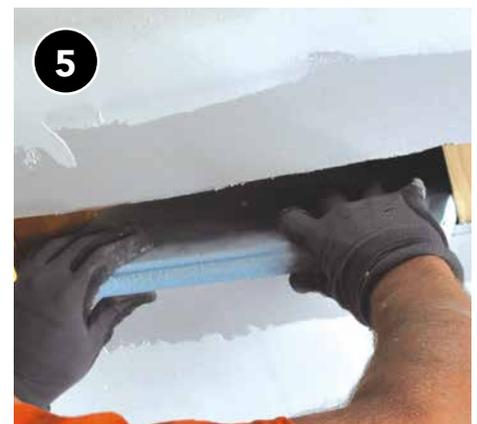
Aún es necesario colocar el bloqueo si las cavidades abiertas se extienden hacia el espacio acondicionado (p. ej., una cavidad debajo de un muro en desnivel en un espacio exterior del ático con viguetas en el techo).
