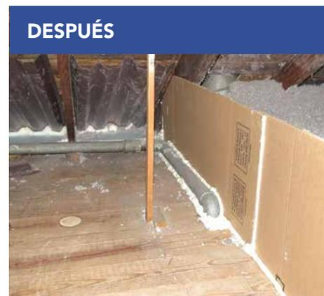
Un piso de ático aislado proporciona una barrera térmica continua, contigua, segura y que cumple con las normas, al limitar el movimiento de aire.
