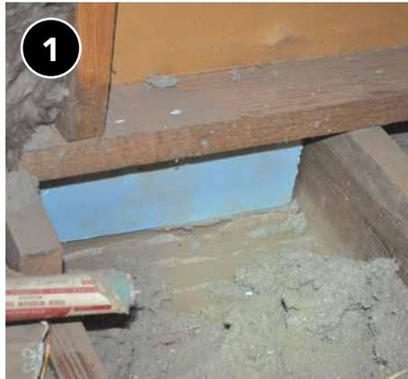
Asegúrese de que las cavidades del piso y las ranuras estén bloqueados de forma segura en ambos extremos, y que todos los bordes del bloqueo estén sellados.
