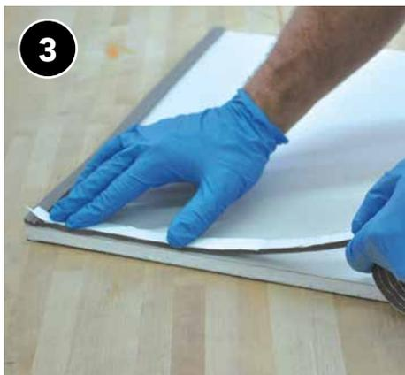
Si es necesario reemplazarlo, corte una placa de yeso o madera contrachapada a la medida y utilice un burlete duradero o cinta de espuma de celda cerrada para crear un sello.
