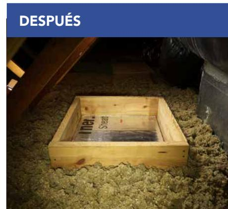
El sellado y aislamiento seguro y duradero de las puertas de acceso al ático evita el movimiento de aire y reduce las cargas de calefacción y refrigeración.
