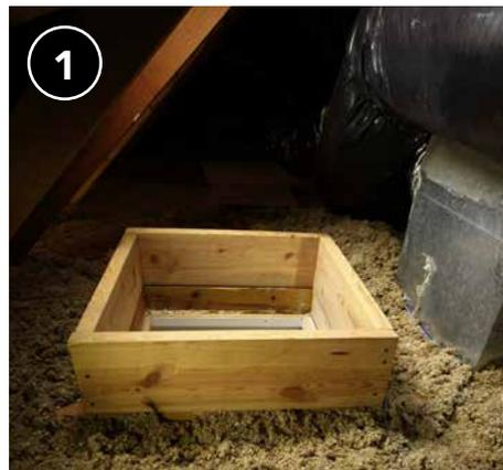
Se instala una represa rígida y duradera y se sujeta mecánicamente en su lugar.
