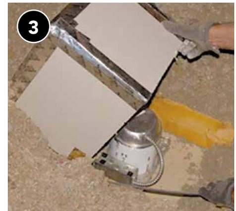
3 Las cajas prefabricadas pueden facilitar la instalación cuando el lugar de instalación está libre de elementos estructurales.
