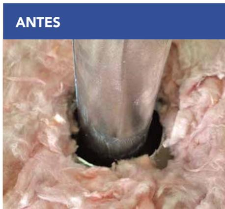
Retire el aislamiento de la chimenea o conducto de humos.
