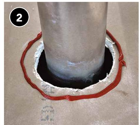
2 Aplique un anillo continuo de impermeabilizante directamente sobre la plataforma limpia de modo que coincida con el perímetro del soporte de metal laminado.
