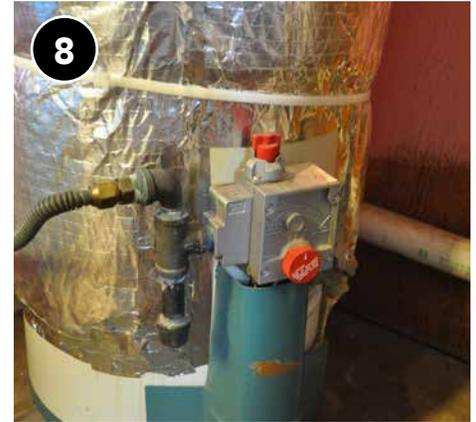
Sujete las uniones con abrazaderas, alambre o cordel y compresión mínima.
