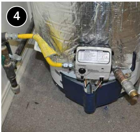
No obstruya la placa de acceso al quemador ni la entrada de aire de combustión.
