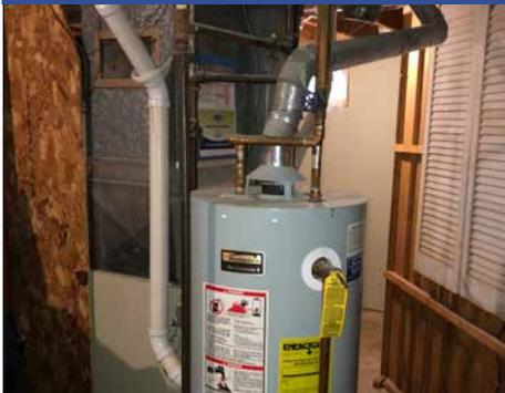
Revise la placa de datos y la etiqueta de advertencia del calentador de agua para conocer el nivel de aislamiento existente y confirmar que el fabricante no desaconseja el aislamiento adicional.
