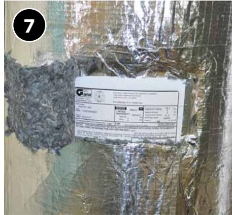
Corte las solapas en las placas de acceso, ciérrelas con cinta adhesiva y luego etiquételas desde el exterior.
