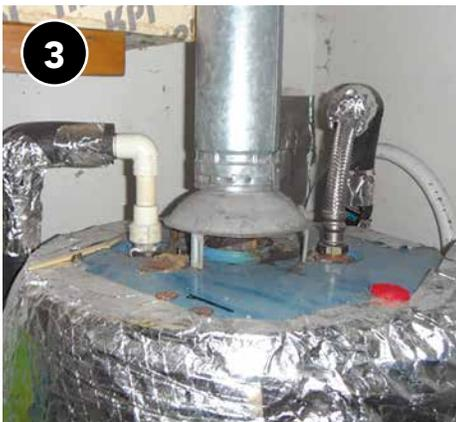
Pegue con cinta aislante la parte superior del calentador de agua mientras mantiene un espacio libre mínimo de 6 pulgadas desde el desviador de corriente.
