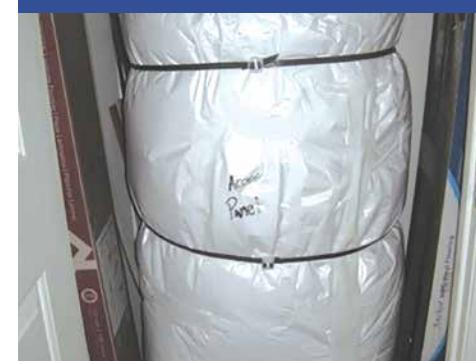
Con las solapas del panel de acceso cortadas y etiquetadas, un calentador de agua aislado correctamente reduce las pérdidas en modo de espera y permite el acceso a los paneles de control del calentador de agua.
