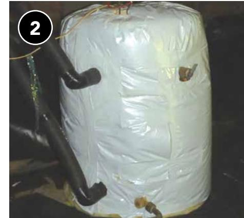
Asegure una barrera de vapor continua sin huecos y marque la ubicación de los cortes de los paneles de acceso o de las características de seguridad, como la válvula de alivio de temperatura y presión.
