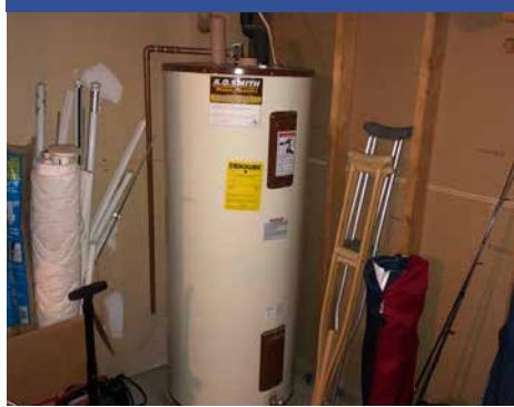
Revise la placa de datos y la etiqueta de advertencia para conocer el nivel de aislamiento existente del tanque y confirmar que el fabricante no desaconseja el aislamiento adicional.
