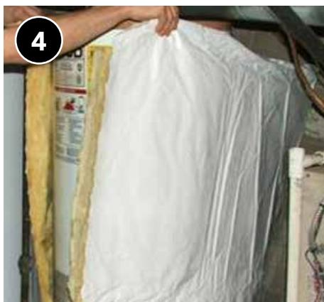
Envuelva con cuidado el aislamiento alrededor del calentador de agua y pegue con cinta adhesiva las uniones y los bordes. Asegure el aislamiento en su lugar con abrazaderas de plástico y evite apretarlos con tanta fuerza que el aislamiento se comprima.
