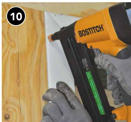
10 Vuelva a instalar el contramarco existente o reemplácelo según sea necesario.
