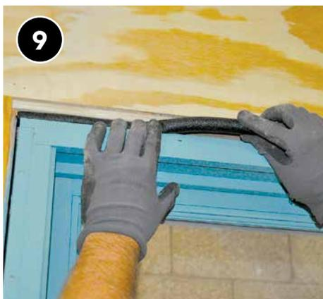
9 Aísle y selle la abertura aproximada con una varilla de relleno o espuma en aerosol de baja expansión.
