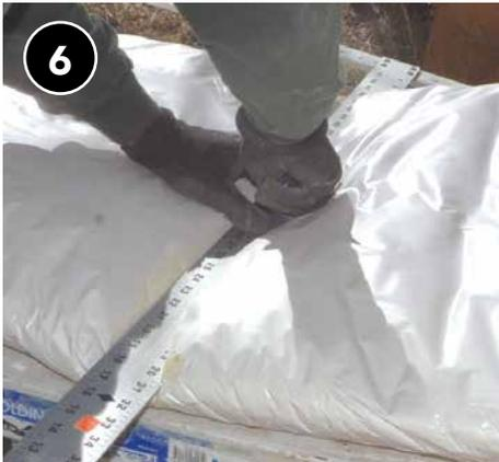
Corte a la medida según el área a cubrir. Aísle todo el metal expuesto de la cámara.
