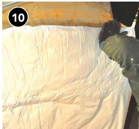
Asegure una adhesión lisa y sin ondulaciones del aislamiento al metal de la cámara.
