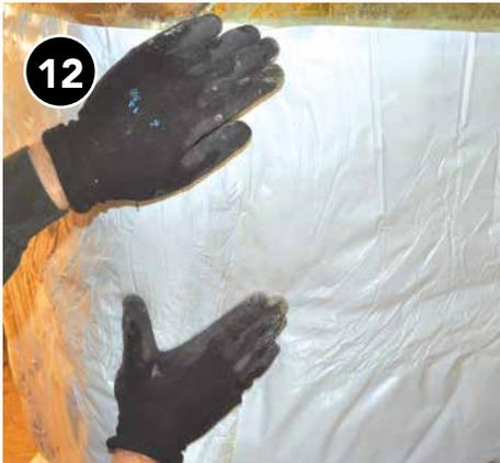
Asegúrese de que la solapa superpuesta esté bien sujeta a la capa inferior para mantener una barrera de vapor completa, o selle las uniones con cinta listada en la norma UL-181.
