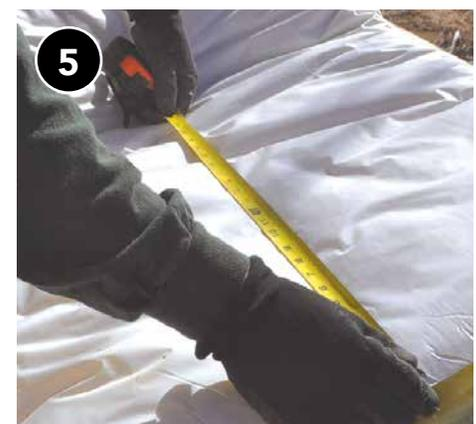
Mida el aislamiento para aprovechar al máximo las láminas grandes del aislamiento para conductos.
