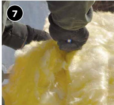
Para asegurar que el retardador de vapor sea completo, recorte el aislamiento de la barrera de vapor para crear una solapa superpuesta en las uniones o cubra las uniones con cinta listada en la norma UL-181.
