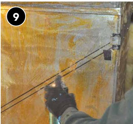
Rocíe adhesivo sobre el área donde se instalará la pieza.
