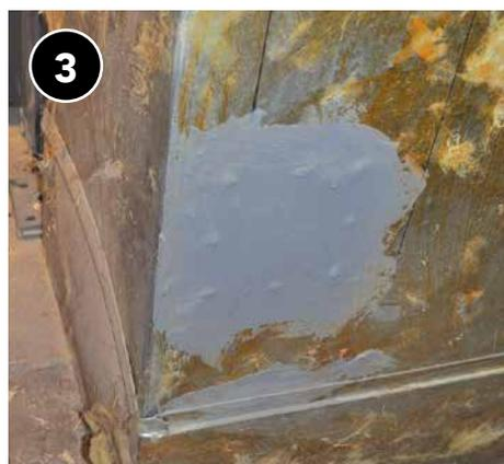
Parche los orificios en los conductos y la cámara con los materiales apropiados (consulte la guía 19-1 Sellado de ductos con resina mástic).
