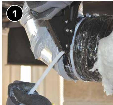
Asegure el revestimiento del conducto flexible a las conexiones rígidas con una abrazadera de plástico y una herramienta tensora. Si utiliza envoltura para conductos, siga el mismo procedimiento después de agregar aislamiento en donde falte, teniendo cuidado de no comprimir el aislamiento.
