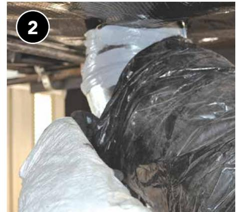
Tire del aislamiento sobre las conexiones rígidas según sea necesario.
