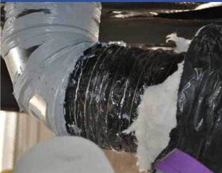
Verifique que los conductos estén conectados y con sellado de fugas de aire en las conexiones metálicas y en cualquier otro orificio dentro del revestimiento. Cuando sea necesario un nuevo conducto flexible, seleccione el aislamiento (envoltura de conductos o conducto flexible) con un valor R-8 como mínimo.
