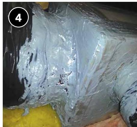
Selle las juntas nuevas donde el aislamiento del conducto se une con la cámara, utilizando material listado por UL.
