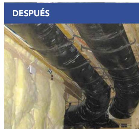
Los conductos con soporte adecuado y uniformemente aislados funcionan con mayor eficiencia.
