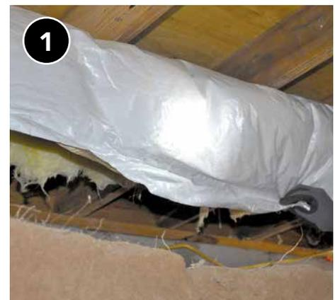
Coloque capas de aislamiento alrededor del conducto y en la conexión entre el conducto y los miembros de la construcción, según sea necesario.
