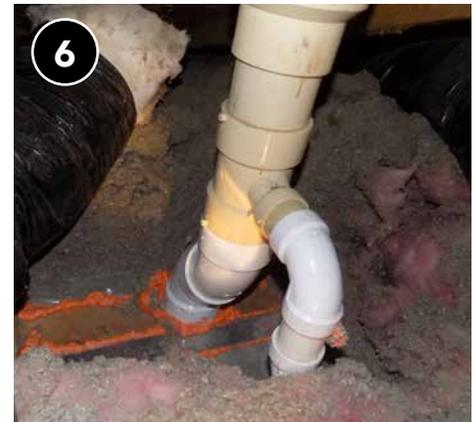
Otras penetraciones, como los tubos de ventilación de fontanería, se pueden sellar con espuma o impermeabilizante con varilla de respaldo, como se describe en el paso 4.
