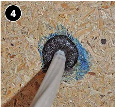
La inserción de una varilla de respaldo proporciona relleno para soportar el sellador.
