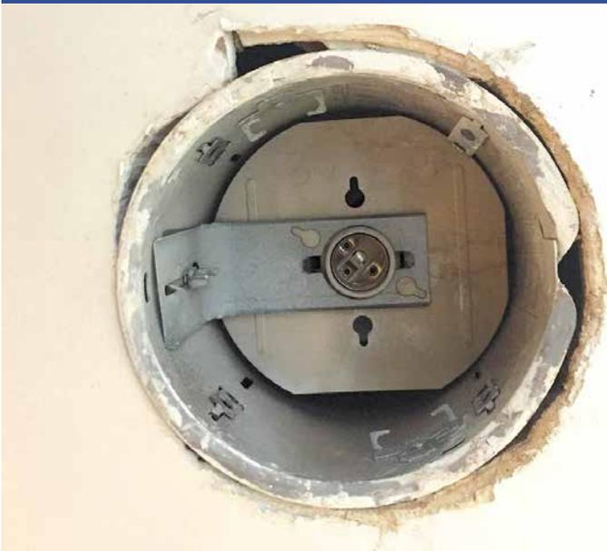
Las luces empotradas con clasificación de contacto con el aislamiento del sellado se instalan comúnmente en el techo, entre el piso superior y el ático, por lo que los huecos a su alrededor facilitan fugas de aire importantes.
