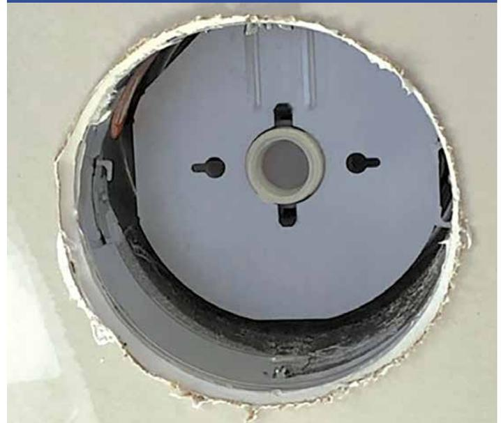
Aplique una gota de impermeabilizante para sellar el hueco entre el dispositivo de iluminación y el techo. Es posible sellar los pequeños orificios en el dispositivo de iluminación instalando una cubierta prefabricada o disponible en el mercado, sobre la lámpara desde el ático. Luego, es necesario sellar los bordes de la cubierta para evitar que el aire acondicionado ingrese al ático.
