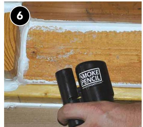
6 Al sellar la parte superior de la cavidad, se detiene el flujo de aire y no debe observarse ningún movimiento de aire al realizar la prueba de humo a una presión de prueba de 50 pascales.
