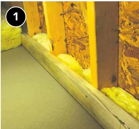
1 Bloquee la abertura de las paredes laterales con armazón de globo en línea con la barrera de presión.
