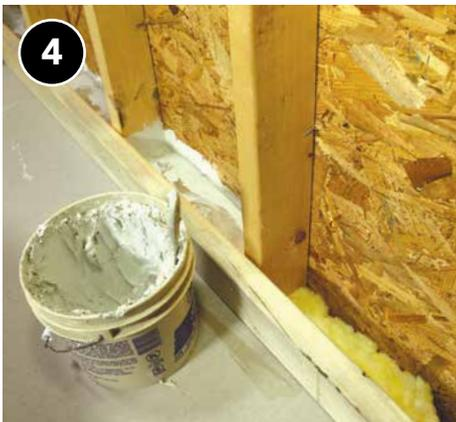
4 Sujete firmemente el material rígido capaz de soportar la presión del aire si las cavidades de la pared estarán densamente compactadas.
