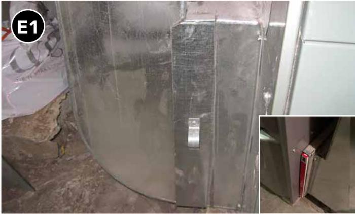
Asegúrese de que las cubiertas de las ranuras del filtro estén instaladas donde falten. Las cubiertas deben sellar la abertura y ser fácilmente removibles para que el ocupante pueda cambiar el filtro.
