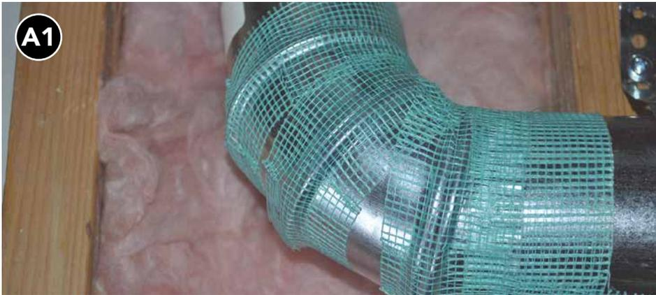
Coloque cinta malla de fibra de vidrio en todos los huecos, uniones, juntas, etc.
