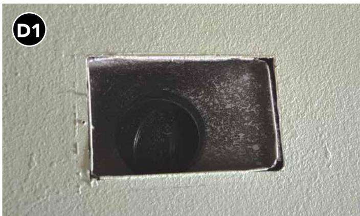
A menudo, los accesorios de transición de los conductos se cortan a un tamaño excesivo y dejan espacios alrededor que permiten fugas de aire.
