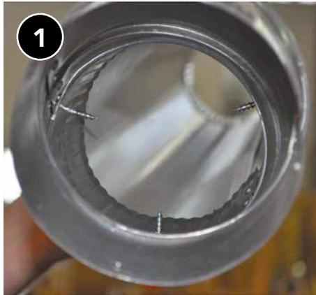
Sujete el conducto rígido con tres tornillos con la misma separación entre sí. Los conductos deben ser de calibre 28 o más gruesos.
