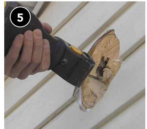
Ubique la ventilación exterior según el tramo del conducto y el tamaño de la cavidad que sea menos de  $\frac{1}{2}$  pulgada más grande que el conducto.
