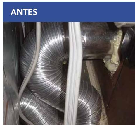
Los conductos de ventilación de una secadora con tramos largos o curvas excesivas crean un peligro de incendio y aumentan el tiempo de secado.
