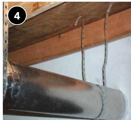
El conducto termina hacia el exterior, con una pendiente hacia abajo cuando sea posible.
