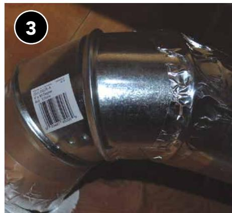
Utilice sujetadores apropiados (sin tornillos que penetren en el conducto).
