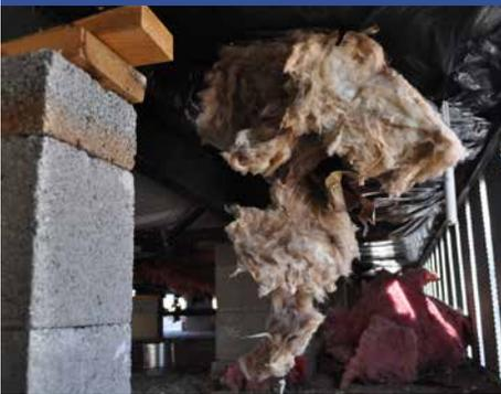
Determine si es necesario realizar reparaciones en la faja central y asegúrese de que no existan problemas de fontanería u otros problemas que impidan el aislamiento adicional. Todo el sellado de conductos debe estar completo y debe identificarse la dirección de las viguetas del piso (transversal o longitudinal).
