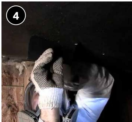
4 Corte orificios de acceso para garantizar que toda la cavidad reciba un aislamiento continuo y consistente.
