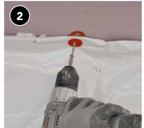
2 Sujete mecánicamente el material de reparación de la faja central. Selle todas las uniones y bordes.
