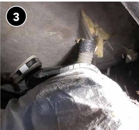
3 Según la preferencia del instalador y las condiciones del sitio, las fajas centrales se pueden aislar por debajo o por el borde cuando se utiliza un tubo de llenado.
