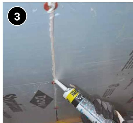
Selle las uniones entre las láminas del material rígido para evitar el movimiento del aire y las fugas de aislamiento.
