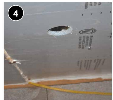
Corte un orificio de acceso en cada cavidad del piso, lo suficientemente grande para introducir el tubo de llenado.
