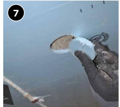
7 Tape el orificio de acceso con el material original cortado o con un material de reemplazo adecuado.
