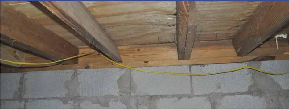
Las cavidades de un piso sin aislamiento son una oportunidad para mejorar el rendimiento térmico de pisos sobre espacios no acondicionados. El aislamiento se puede soplar si se coloca una barrera rígida o una red en la parte inferior de las viguetas del piso.
