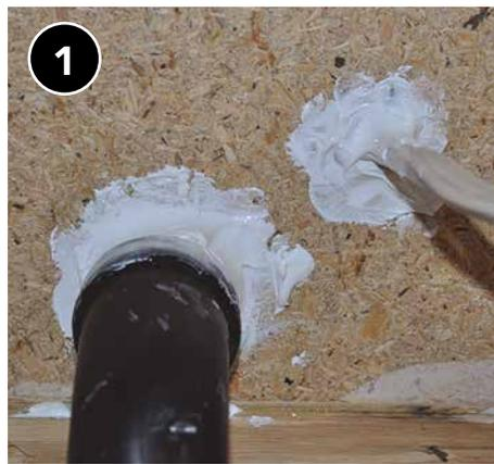
1 Asegúrese de realizar el sellado de fugas de aire antes de agregar aislamiento.
