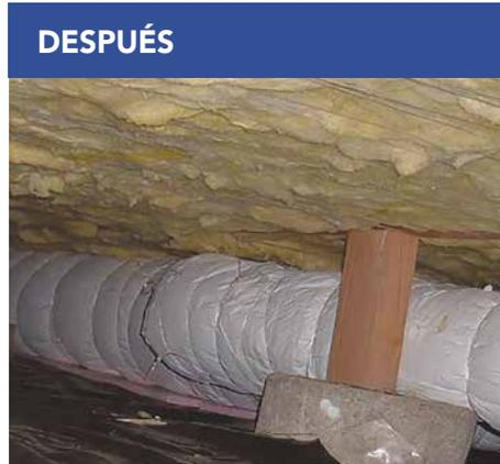
El aislamiento con cobertura completa en contacto con el contrapiso mejorará el rendimiento térmico del ensamblaje del piso.
