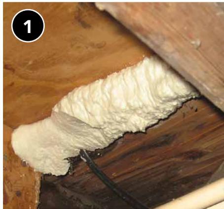
La espuma en aerosol se expande para llenar agujeros grandes, pero puede necesitar protección contra incendios (p. ej., una barrera térmica o de ignición).
