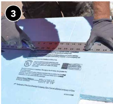
Corte el relleno rígido prestando atención a la ubicación de tuberías e instalaciones eléctricas.
