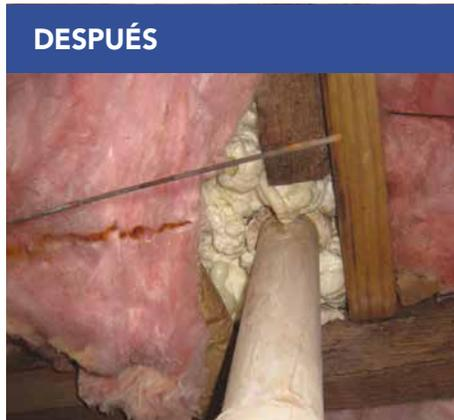
Dependiendo del tamaño del hueco, se puede utilizar espuma en aerosol de una parte, o una combinación de material de relleno y espuma o impermeabilizante.
