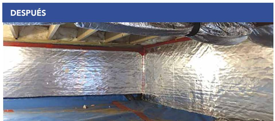
El aislamiento es o tiene un retardador de vapor de clase II del lado del espacio acondicionado. El aislamiento se superpone debajo del retardador de vapor del suelo en la pared de los cimientos.
