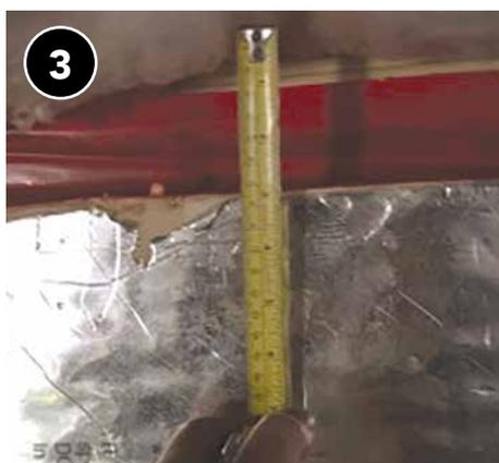
De ser necesario, deje un espacio de inspección de termitas de 3 pulgadas entre la parte inferior de la placa de umbral en la parte superior del aislamiento.
