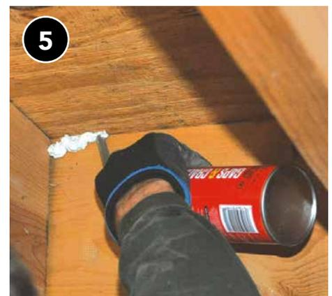
Empuje el sellador en las uniones entre los miembros del armazón mientras instala un hilo continuo alrededor de los cuatro lados del hueco de apoyo, incluidos los espacios en la placa de umbral.
