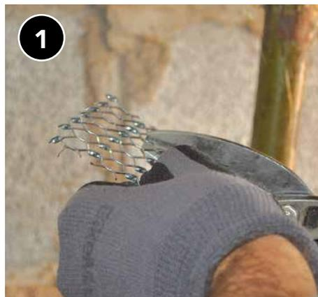
Para orificios exteriores de más de 1/4 de pulgada, utilice lana de acero u otro material de bloqueo de plagas antes de sellar.
