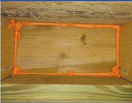
Se logra un sellado continuo y el hueco de apoyo está listo para el aislamiento. Nota: si utiliza espuma de dos partes para aislar y sellar contra fugas de aire, el paso 5 se puede lograr rociando los bordes exteriores del hueco de apoyo mediante una técnica de enmarcado y luego trabajando hacia el interior de la cavidad para aislarla.
