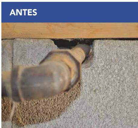
Es necesario solucionar el movimiento de aire alrededor de las placas de umbral y cerca de las viguetas de soporte lateral antes de realizar el aislamiento.
