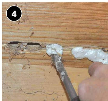
Selle las penetraciones (eléctricas, de plomería, agujeros vacíos, etc.) en el contrapiso, que se ubiquen en el hueco de apoyo de la vigueta de soporte lateral.
