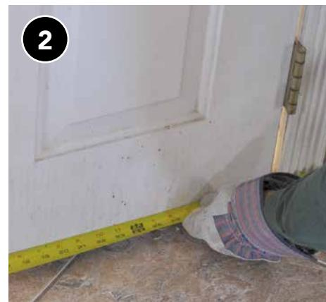
Las puertas exteriores con filtración de luz o flojas son indicadores comunes de fugas de aire. Realice los ajustes necesarios (p. ej., bisagras, perillas, contrachapas y demás componentes que estén flojos) en la puerta antes de colocar los burletes.
