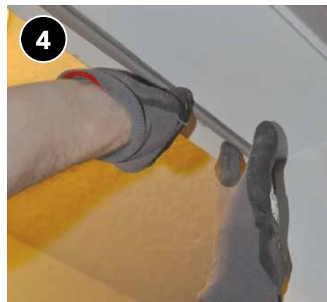
Coloque el burlete de manera ajustada, después de aplicar una pequeña gota de impermeabilizante, y alinéelo con los orificios para tornillos en la parte posterior del burlete.
