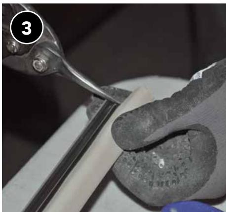
Si el fabricante no proporciona una muesca, haga una en los extremos de cada pieza lateral del burlete para permitir un ajuste hermético con la pieza superior.
