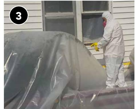
3 Cierre todas las puertas y ventanas a un perímetro de 20 pies del área de trabajo. Tenga en cuenta que las puertas utilizadas como entrada al área de trabajo deben estar cubiertas con revestimiento plástico para permitir el acceso de los trabajadores y evitar la propagación del polvo.
