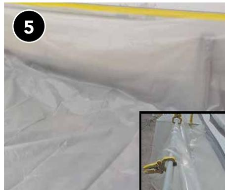
5 Pegue con cinta plástica la superficie de trabajo y utilice sistemas para atrapar los escombros al tiempo que limita el daño a las plantas exteriores.
