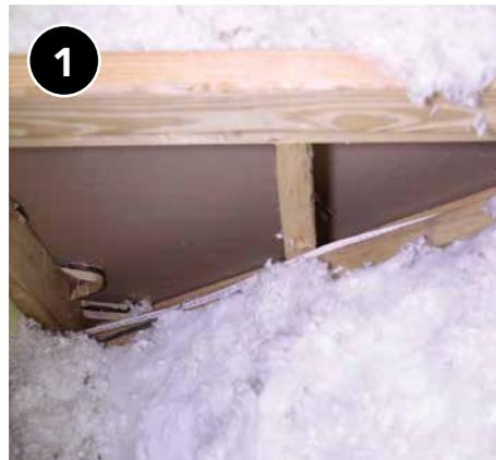
Si las paredes que definen la barrera térmica son accesibles desde el lado del ático, elija entre aislamiento de guata o soplado.
