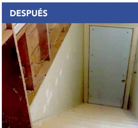
El aislamiento proporciona una barrera térmica continua, contigua, segura y compatible que evita el movimiento de aire entre el ático y el resto de la casa.
