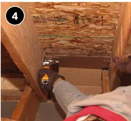
4 Instale deflectores, si es necesario. Asegure de dejar un espacio de 1 a 2 pulgadas entre el deflector y la plataforma del techo para que fluya el aire.
