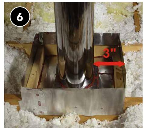
6 Las represas se construyen alrededor de fuentes de calor y el sellado de fugas de aire se realiza con materiales aprobados (p. ej., tapajuntas de metal, selladores aptos para altas temperaturas, etc.). Las represas deben ser más altas que la profundidad final de cualquier aislamiento nuevo. Tenga en cuenta que el espacio libre entre las represas y el aislamiento puede variar; siga las instrucciones de la autoridad competente.
