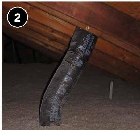
2 Dirija los conductos del extractor hacia el exterior y aisle el conducto a R-8.
