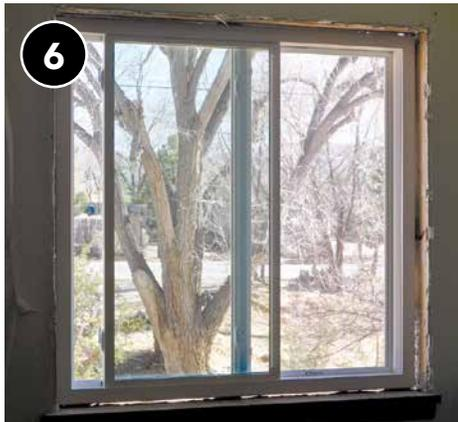
6 Nivele la ventana con calzas y asegúrela con sujetadores mecánicos siguiendo las especificaciones del fabricante.
