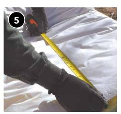
Mida el aislamiento para aprovechar al máximo las láminas grandes del aislamiento para conductos.
