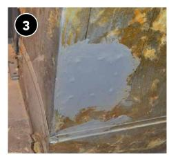
Parche los orificios en los conductos y la cámara con los materiales apropiados (consulte la guía 19-1 Sellado de ductos con resina mástic).
