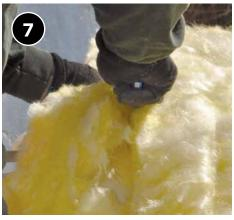
Para asegurar que el retardador de vapor sea completo, recorte el aislamiento de la barrera de vapor para crear una solapa superpuesta en las uniones o cubra las uniones con cinta listada en la norma UL-181.
