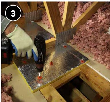
Aplique sellador a lo largo de las placas superiores, los refuerzos y los miembros estructurales antes de fijar el material rígido, y asegúrelo en su lugar con sujetadores mecánicos.
