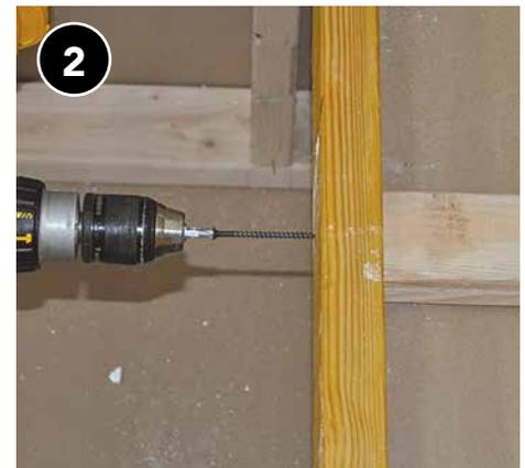
De ser necesario, fije firmemente refuerzos a través de las viguetas, con una separación no mayor a 24 pulgadas.
