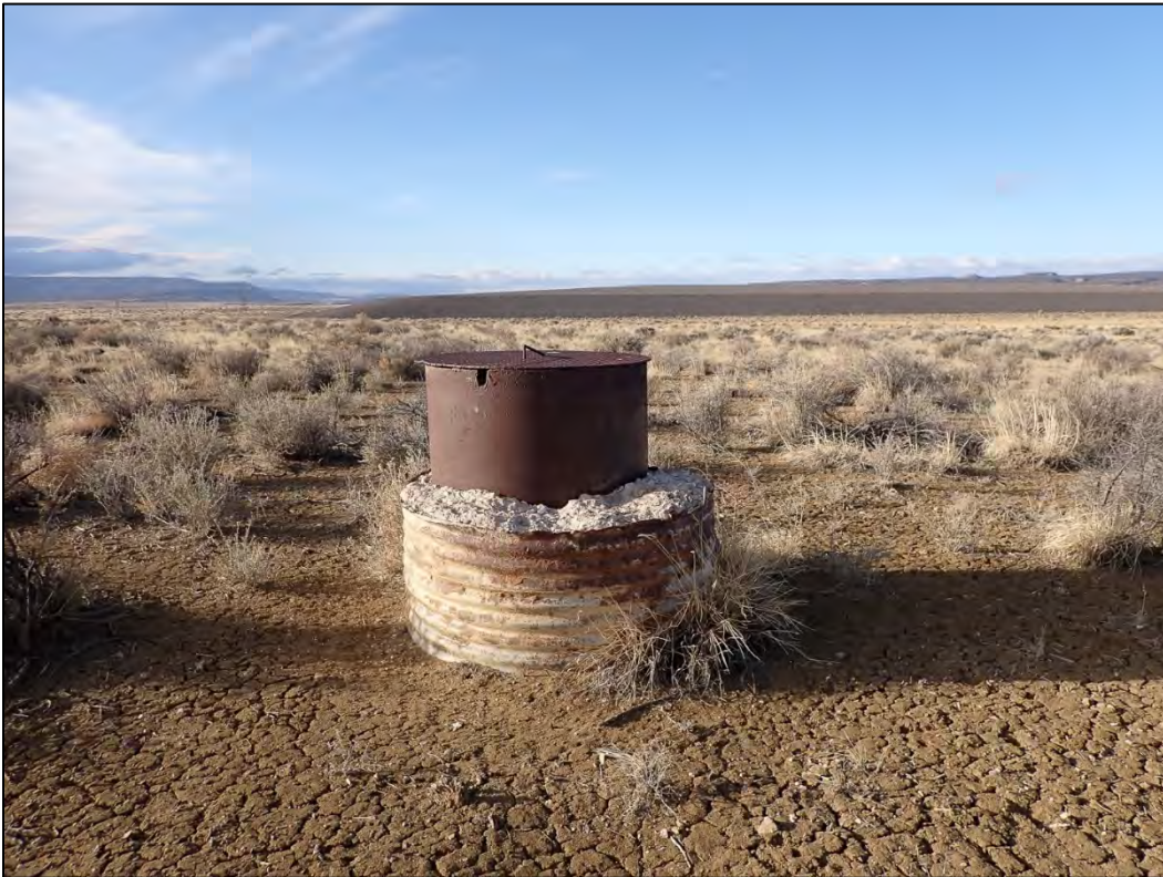
PL-8. Mine Vent Shaft
