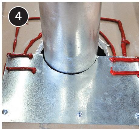
4 Coloque la primera capa de metal laminado en su lugar, dejando un espacio de no más de 1/4" alrededor de la chimenea. Fije mecánicamente el metal laminado al armazón adyacente y aplique impermeabilizante adicional donde se superpondrá la segunda pieza de metal laminado.
