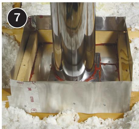
Instale una represa fija y duradera, al menos 2 pulgadas por encima del nivel de aislamiento final, manteniendo todos los materiales combustibles a una distancia mínima de 3 pulgadas de la chimenea o conducto de humos.
