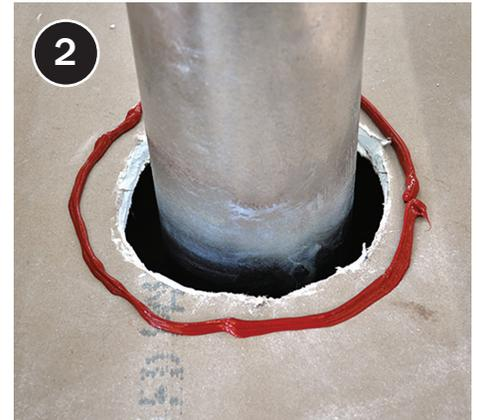
2 Aplique un anillo continuo de impermeabilizante directamente sobre la plataforma limpia de modo que coincida con el perímetro del soporte de metal laminado.
