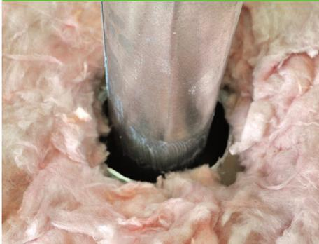
Retire el aislamiento de la chimenea o conducto de humos.
