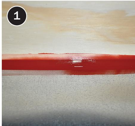
1 Seleccione un impermeabilizante para altas temperaturas que sea flexible ante cambios de temperatura entre los materiales.
