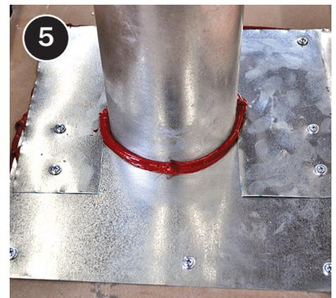
5 Coloque la segunda capa de metal laminado en su lugar. Fije mecánicamente la segunda pieza de metal laminado a la primera pieza, utilizando tornillos de 1/4" para metal laminado, y luego asegure el metal a la estructura adyacente con tornillos más largos.
