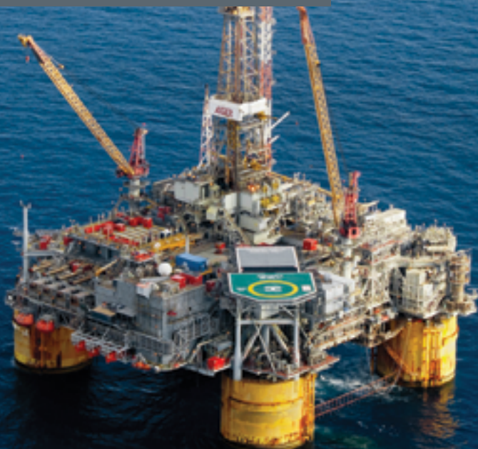
La plataforma de cables en tensión Auger de Shell en el bloque 426 de Garden Banks está amarrada al lecho marino bajo 2,360 pies de agua.
