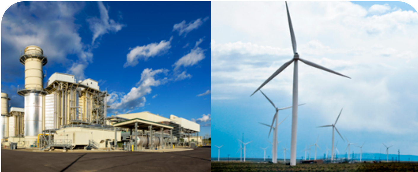
Las plantas generadoras de electricidad flexibles alimentadas con gas natural (izquierda), ayudan a garantizar que la energía eólica siga siendo confiable (derecha).
