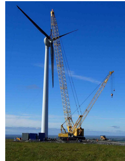
900 kW EWT Wind turbine on St. Mary's Village, Alaska. Photo courtesy of AVEC
