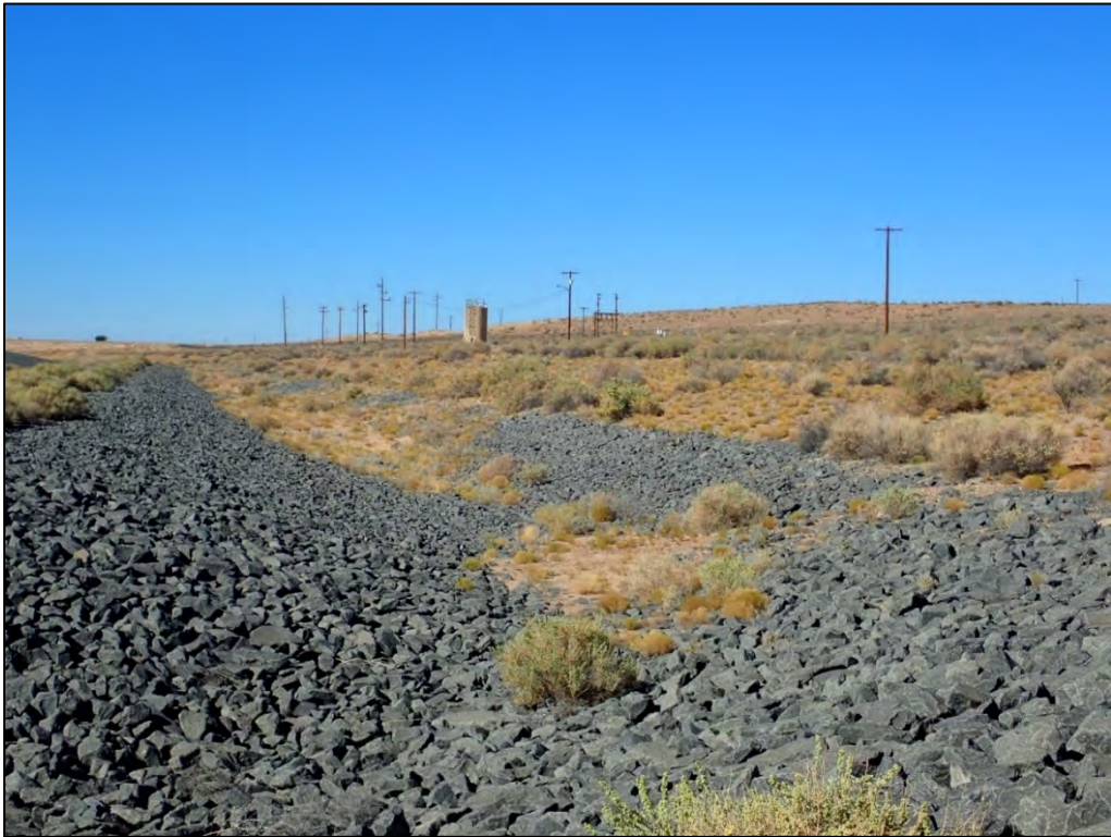
PL-8. Diversion Channel
