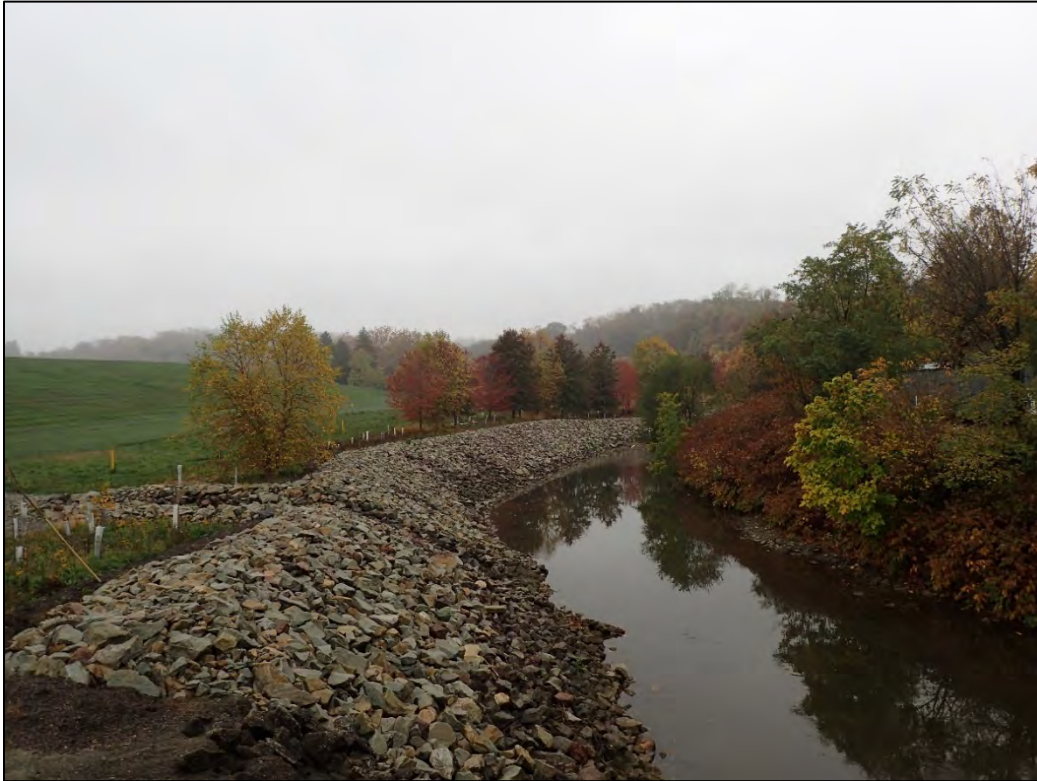
PL-9. Riprap Embankment
