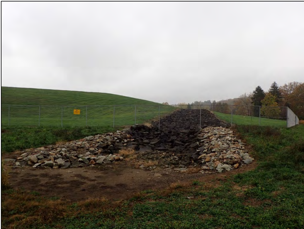
PL-8. Riprap Diversion Ditch Outlet
