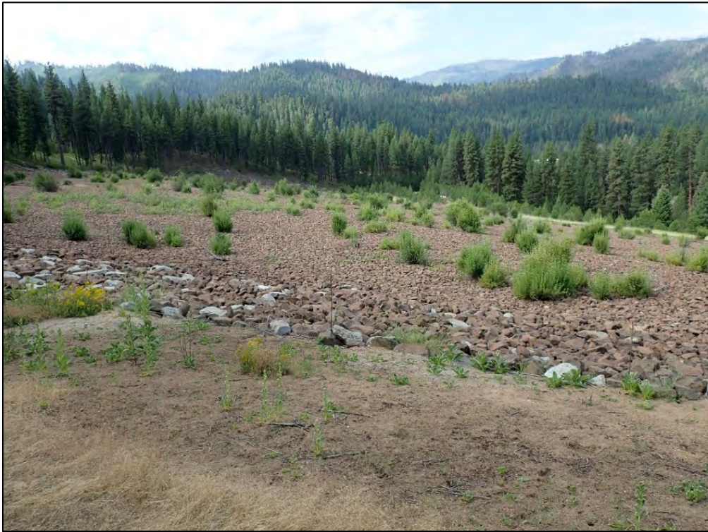
PL-4. Disposal Cell Apron
