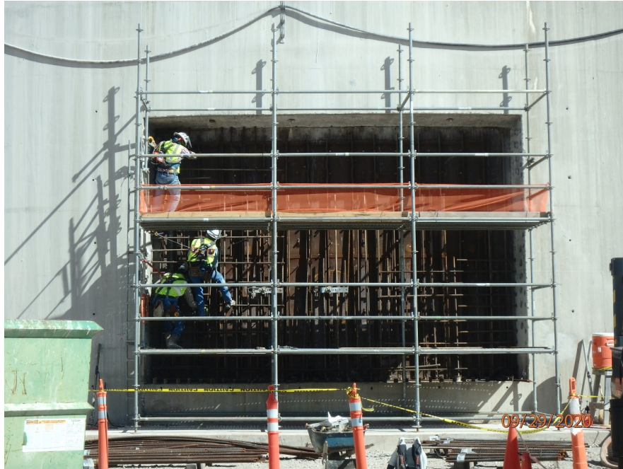
LNG Tank B - rebar installation at west wall
