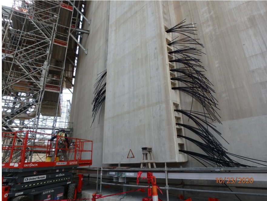
LNG Tank B post tensioning in progress
