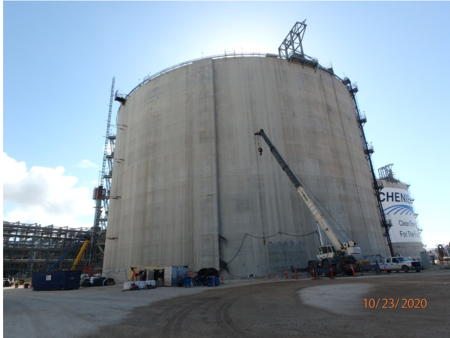
LNG Tank B overview progress
