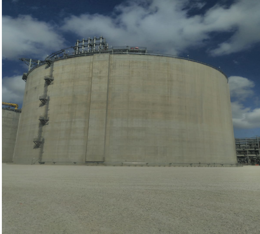
LNG Tank B final grade complete
