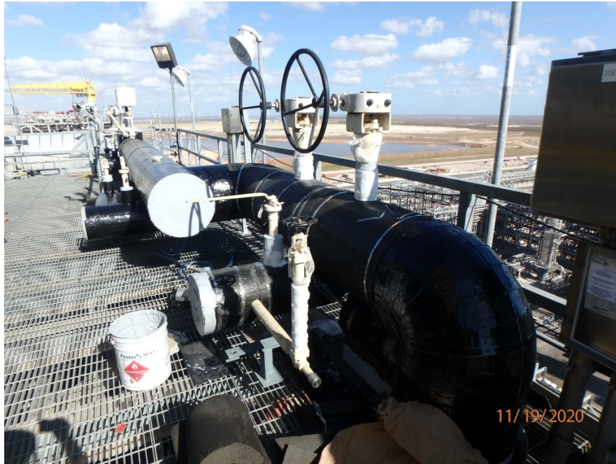
LNG Tank B - piping insulation in progress
