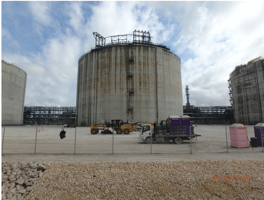
LNG Tank B final grading in progress
