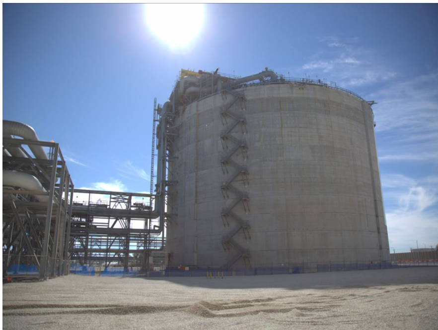
Final grading south side of LNG Tank B
