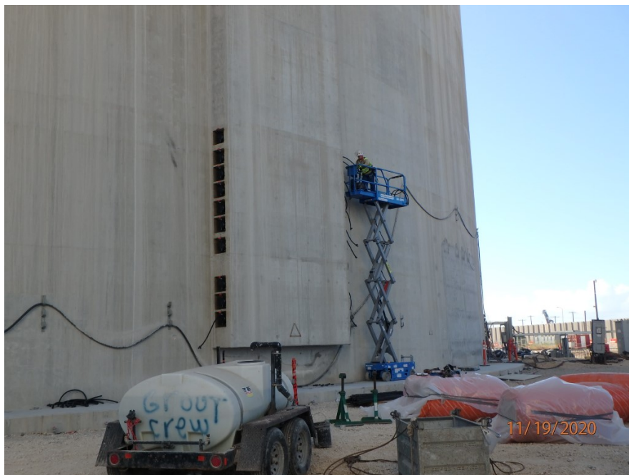
LNG Tank B - post tensioning in progress
