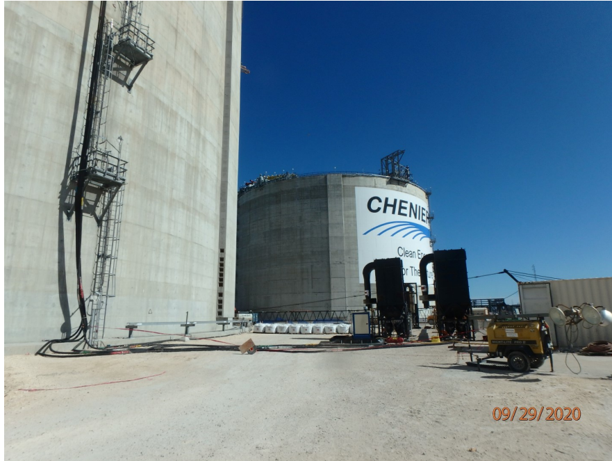
LNG Tank B - perlite installation in progress
