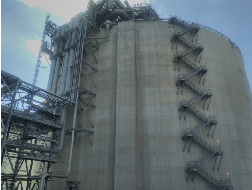
LNG Tank B ready to turn over
