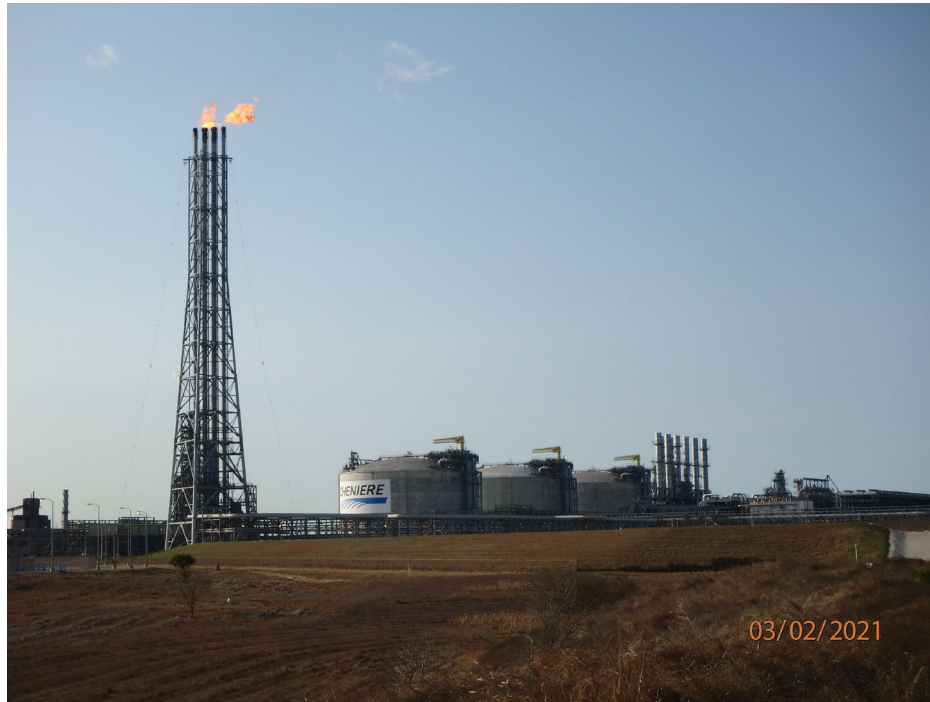
Train 3 continue LNG production
