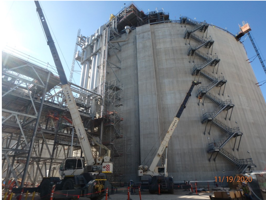
LNG Tank B - waterfall piping insulation complete
